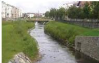
Figura 4.5.5.5 Vista del río Artia rehabilitado a su paso por Irún (Guipúzcoa, España) (foto: Paola Sangalli).
