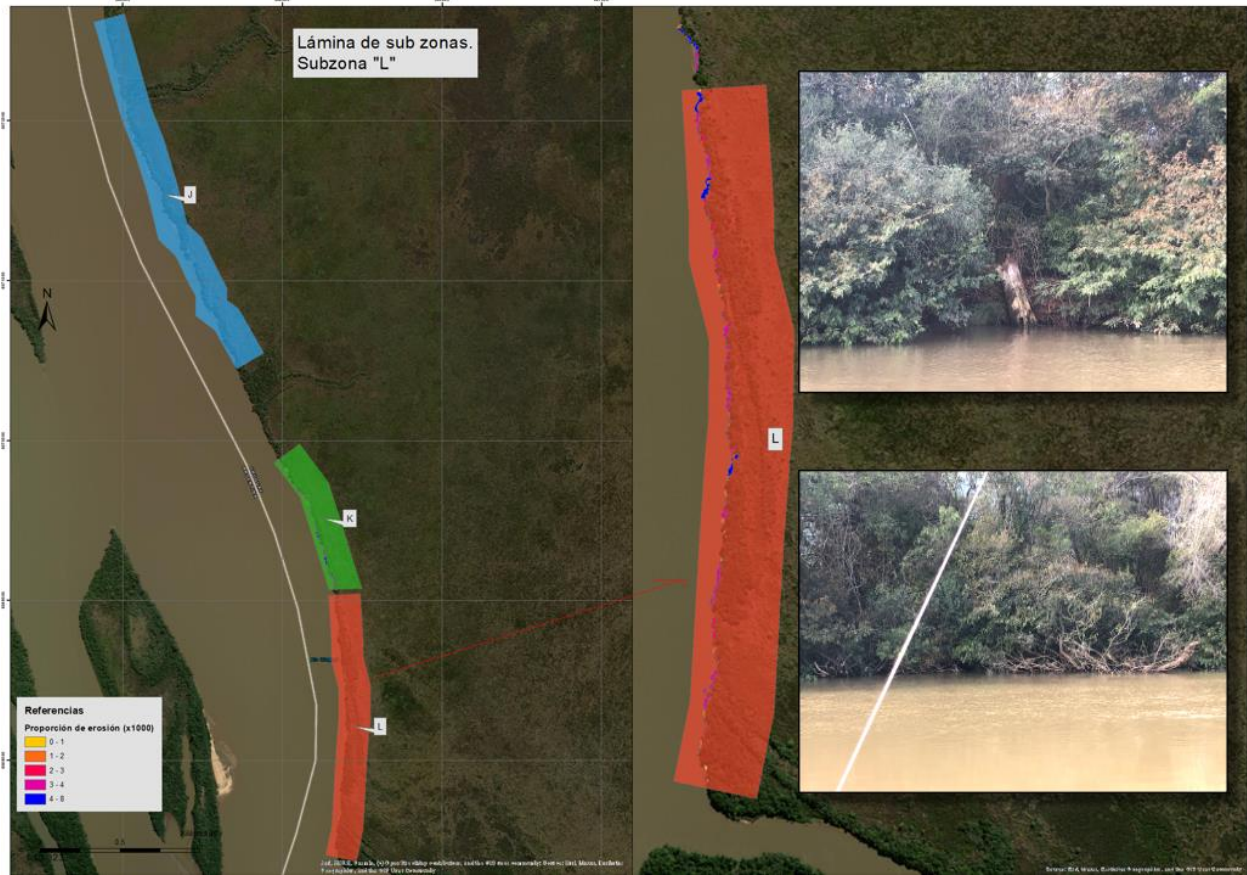
Figura 3.2.8. Detección en la zona L de retroceso de la línea de costa mediante comparación de imágenes satelitales 2013-2017. Fotografía tomada en zona L registrando erosión costera (Agosto 2023).
