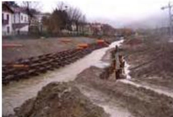
Figura 4.5.5.4 Construcción de un entramado de madera en tramo urbano, Río Artia (Guipúzcoa) (foto: Paola Sangalli).
