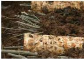
Figura 4.5.5.3 Colocación de estacas de sauce en las celdas del entramado de madera y cubiertas con tierra vegetal (foto: Antoni Bonafont).
