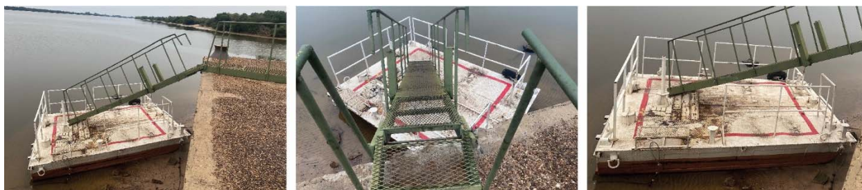
Imágenes tomadas en muelle de San Javier
