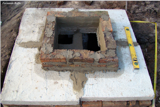
Figuras 11a y 11b. Imágenes de cámara séptica triple de sección cuadrada con una sola tapa para mantenimiento de los tres compartimentos.
