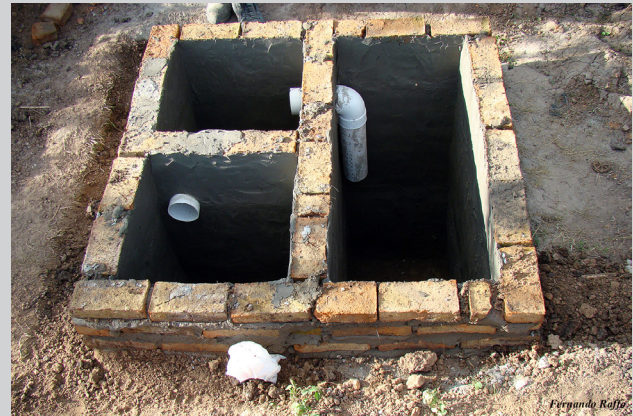
Figuras 11a y 11b. Imágenes de cámara séptica triple de sección cuadrada con una sola tapa para mantenimiento de los tres compartimentos.
