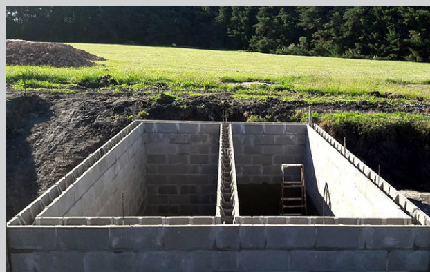
Figuras 14a y 14b. Vista de cámaras dobles de tabiques de hormigón armado construido en obra y bloques de cemento con estructura de hierro, aprovechando los huecos a modo de encofrado perdido
