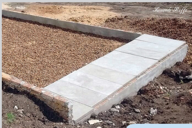
Figuras 12a y 12b. Imágenes de cámara séptica de sección rectangular, con tapa corrida, elaborada en obra.
