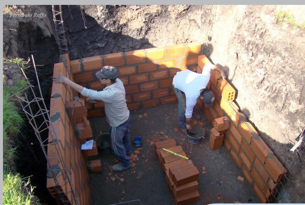
Figura 13a y 13b. Construcción con bloques cerámicos e impermeabilización con revoque de cemento y arena más hidrófugo.
