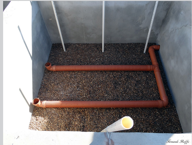
Figura 20 (izq.): vista de la prueba hidráulica de la cañería de ingreso, luego se recubre con 10 cm de piedras. Figura 21 (der.): vista de la cañería de captación en donde falta conectar los caños de los respiraderos para que trabajen a presión atmosférica evitando sellos hidráulicos de aire que dificultan el vaciado del humedal.
