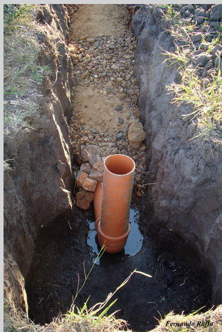
Figuras 49a y 49b. Vistas del tendido de caños en una zanja de infiltración y el venteo al final del tramo.
