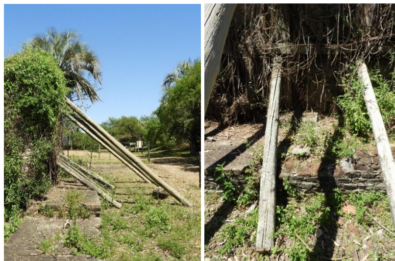
El apuntalamiento visto desde el este (izq.) y detalle del estado de los rollizos usados de puntales (der.).
