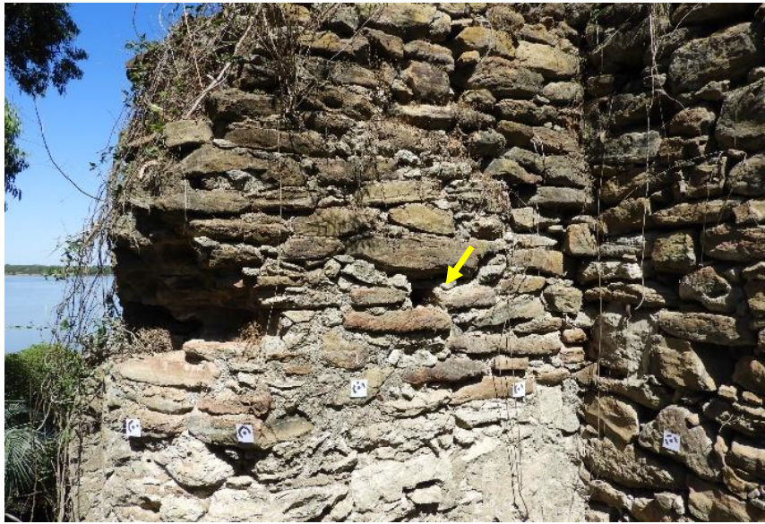
El paño sur del muro este del Depósito en octubre de 2022. La flecha indica el hueco dispuesto para recibir el cabezal de una de las vigas de madera del entrepiso.
