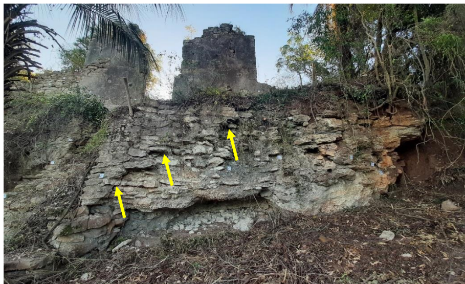
Vista del Socavón Norte y del deslave (al centro y en el extremo derecho de la imagen), en noviembre de 2022. Las flechas indican el sector del muro de contención de piedra que se mantiene en posición. Los mampuestos caídos deben estar sobre la costa, tapados por sedimentos y materia orgánica.
