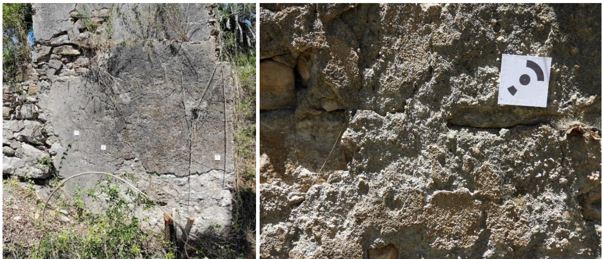
El revoque exterior del muro este (izq.) y detalle del que se encuentra sobre el muro norte (der.) donde el punto de control -con sus 8 cm por lado- da idea de la escala.
