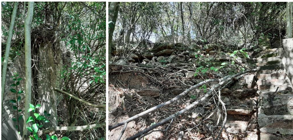
Muros, plataformas y escalera ubicados en la parte alta.
