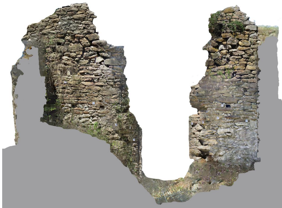
Ortofoto de la cara interna del muro este del depósito, con los puntos de control colocados para el relevamiento.
