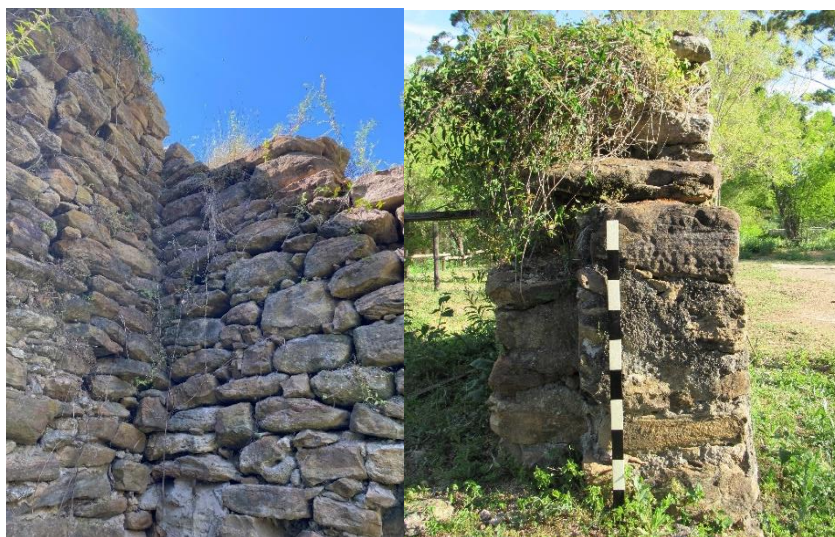
El ángulo sureste del Depósito construido con mampuestos acomodados (izq.) y detalle del canteado en la jamba subsistente en el muro oeste.
