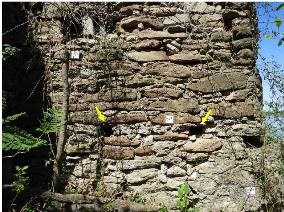
El paño norte de la cara interna del muro este mostrando -en este caso- dos de los huecos. El de la derecha es el que se muestra en el detalle que sigue.
