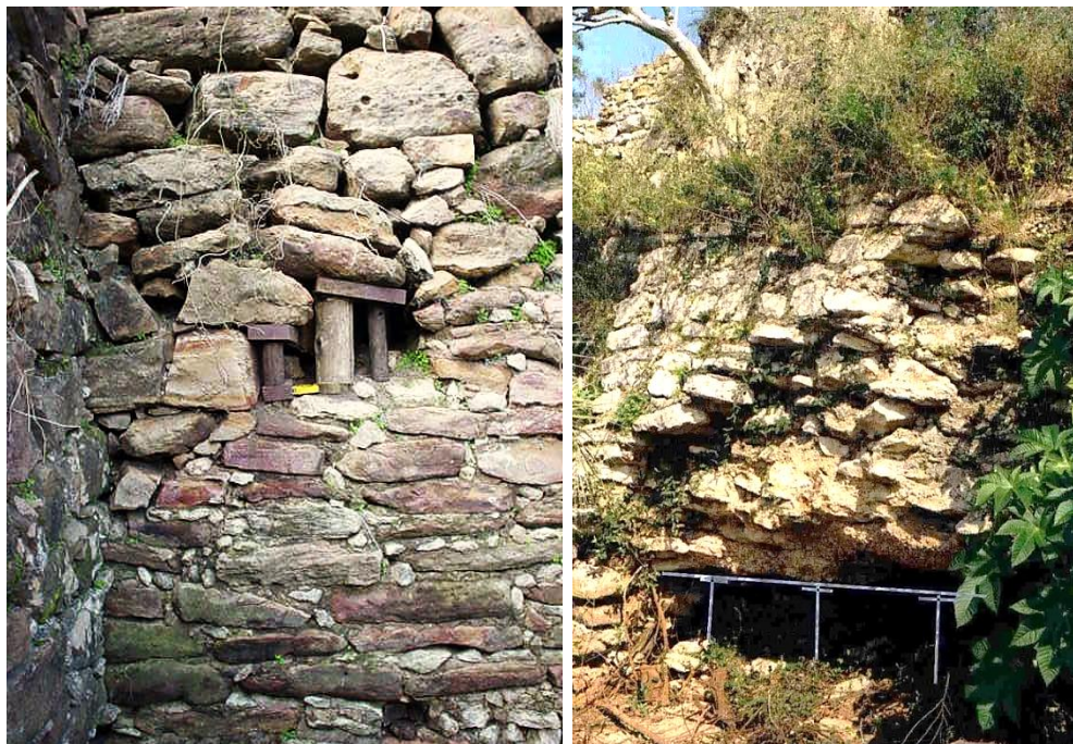
Apuntalamientos ejecutados en el Depósito y proyectados en el Socavón Norte.
