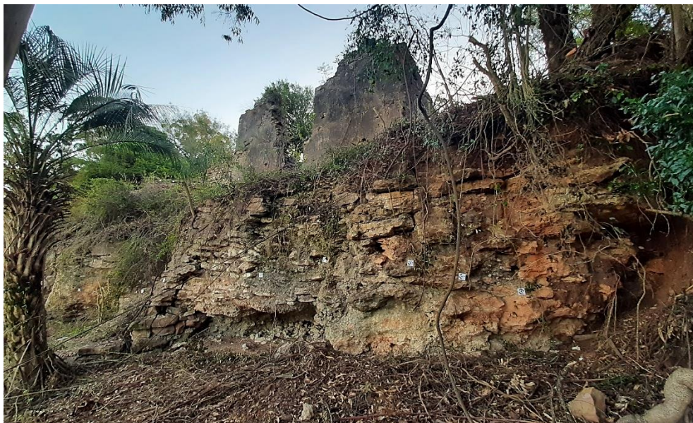
Vista de la barranca desde el sector norte tomada en noviembre de 2022. Se observa el socavón norte y el deslave, éste último en el extremo derecho de la imagen.
