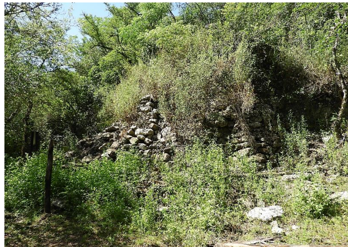
Derrumbe sobre el lado norte del horno.
