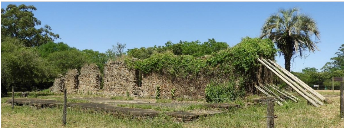
Vista del Almacén desde el noreste.
