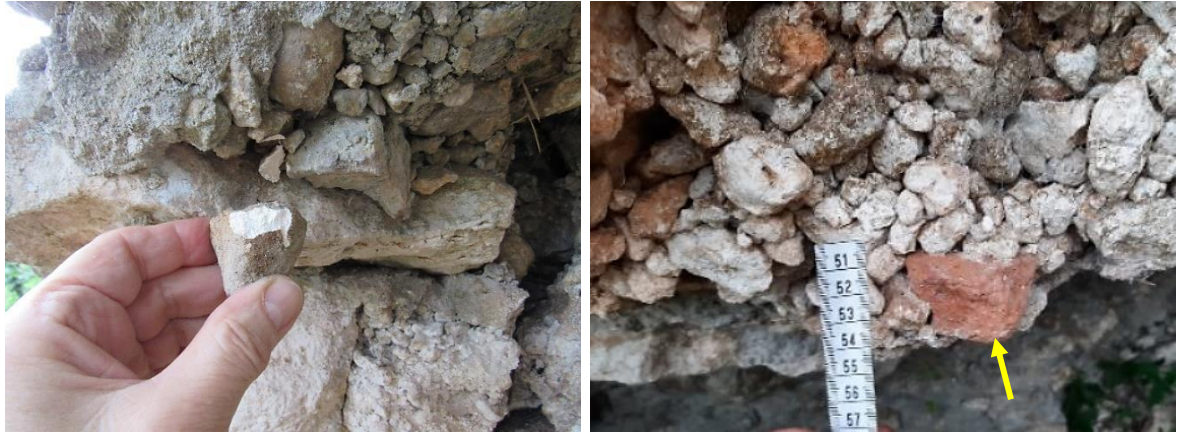
Detalle del tipo y tamaño de los agregados del hormigón (escala en cm), que por su aspecto parecerían ser calizas. En la imagen de la derecha se observa la presencia de un fragmento de ladrillo común incluido en la matriz (flecha).
