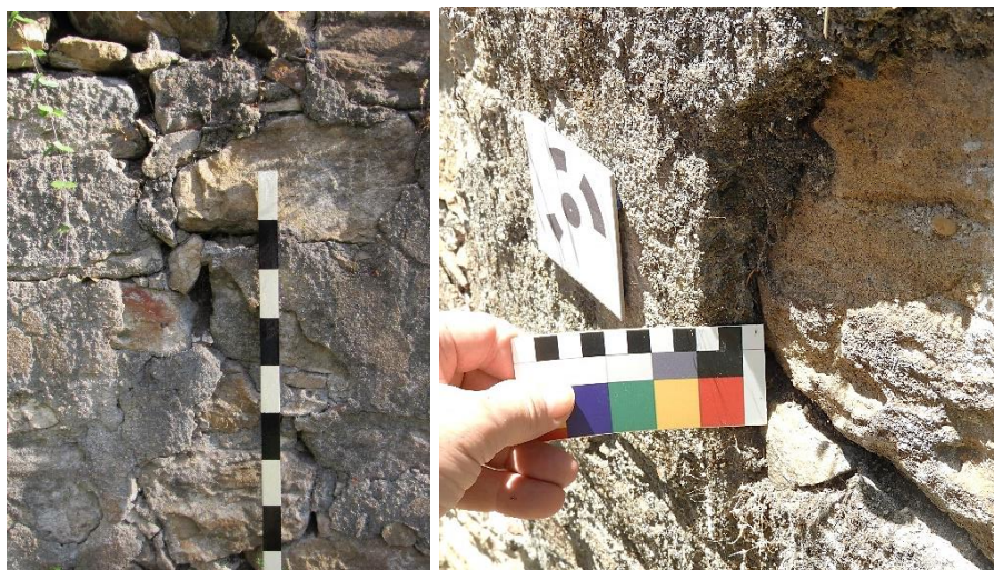
Dos detalles del revoque del muro norte. Vista (izq) escala 1 = 10 cm y espesor (der.) escala 1 = 1 cm.
