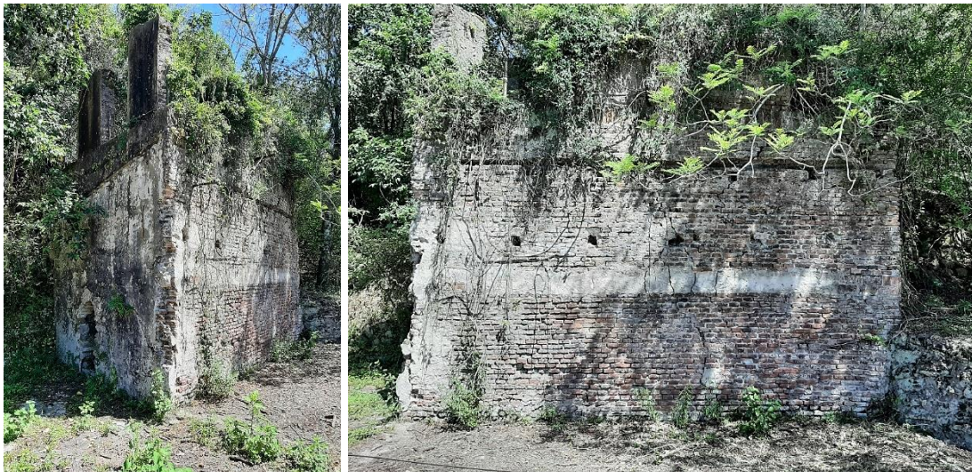
Vista del ángulo sur este (izq.) y del muro este de la estructura (der.)
