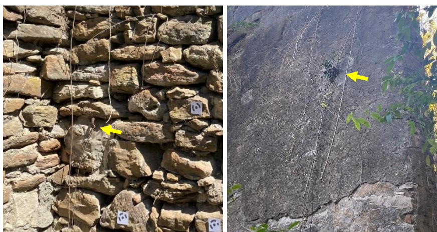
La flecha señala la posición de las grampas en el muro sur del Depósito, cerca del ángulo sureste del mismo (izq.) y en el exterior del muro este (der.).
