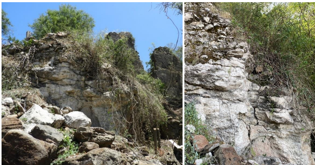
Vista del sector de la barranca a estudiar (izq.) y detalle de la misma en que se observan grietas y fracturas (der.).
