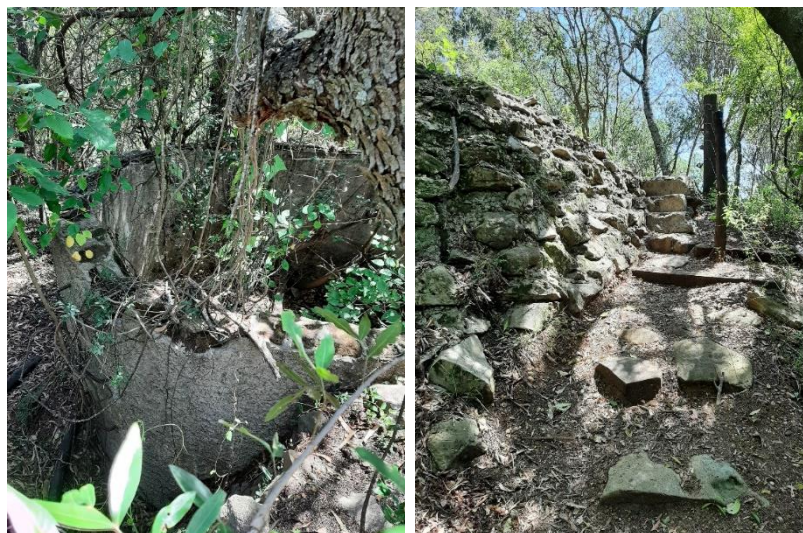
Dos de las construcciones ubicadas en la parte alta de la Calera de Morand.
