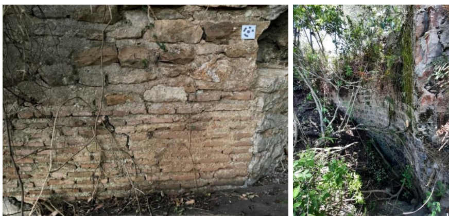
El muro de contención de la barranca (izq.) y el interior del Horno 2 (der.).
