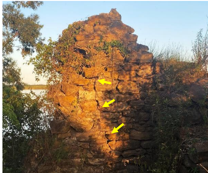
Conformación de una línea de falla por la disposición de las juntas verticales en el muro este.
