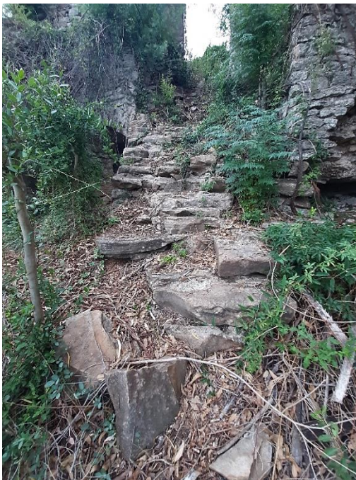
Vista completa de la escalera (izq.) y el lateral del tramo central (der.). Se observa una parte de los mampuestos desprendidos y desplazados.
