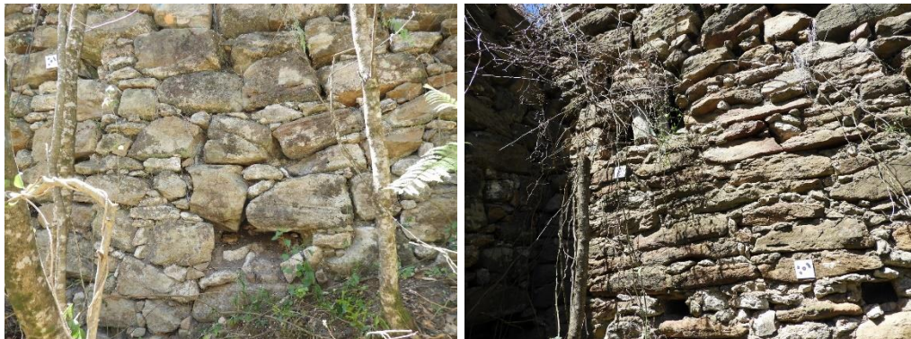
Muros norte (izq.) y este (der.) del ángulo noreste del Depósito. Nótese la diferencia en la forma de colocación de los mampuestos y de las trabas en un mismo sector del recinto.
