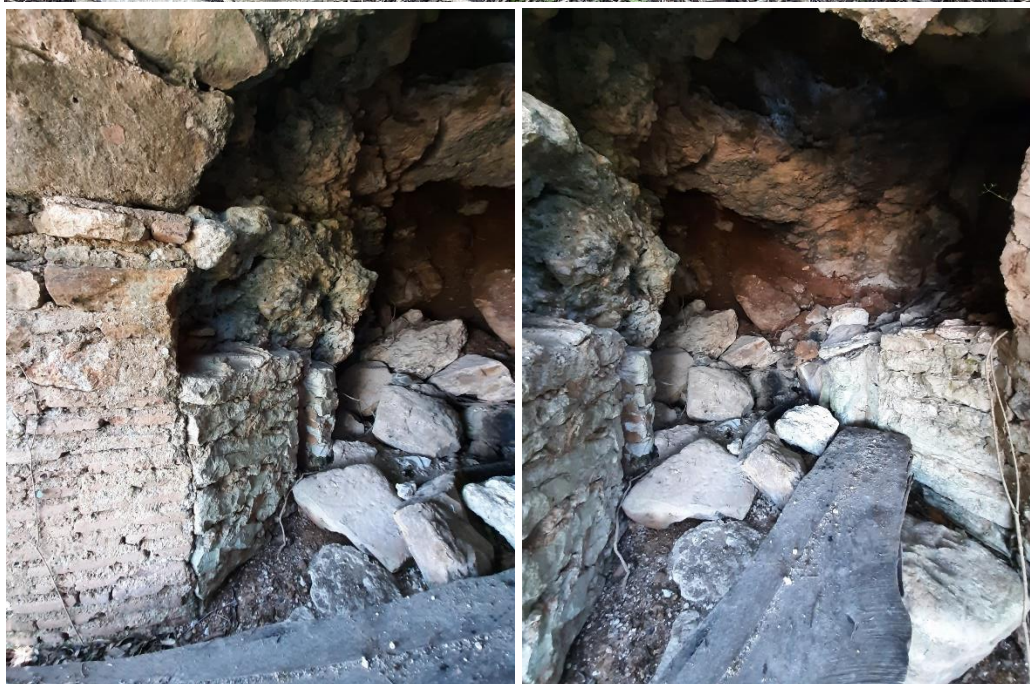
Vista del vano de acceso (arriba) y del interior (abajo), donde se observan los muros que conformarían las plataformas y una serie de piedras caídas sobre el piso, posible producto del derrumbe de lo que habría sido la cubierta de ese espacio.
