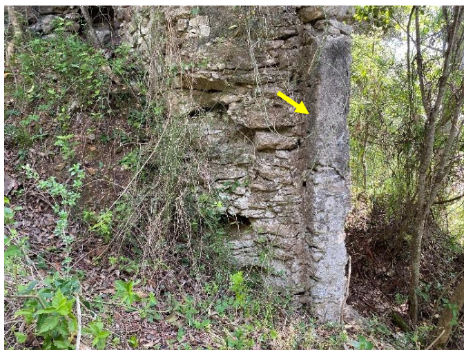
Detalle de la jamba con la saliente.
