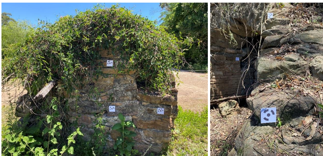
Puntos de control colocados en la cara interna del muro oeste del Depósito (izq.) y en la escalera que lo vincula con la playa (der.).
