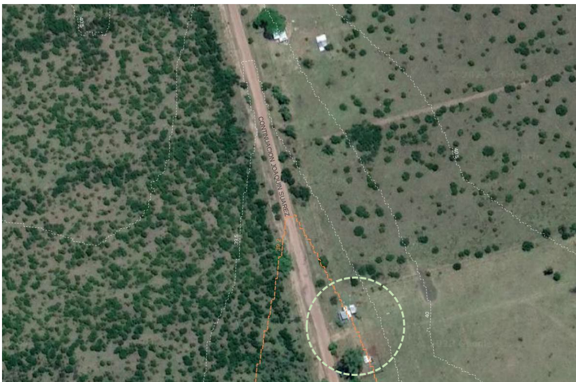
1as Viviendas Franquía. Construcciones ubicadas en zonas más bajas que se interpretan como viviendas.
