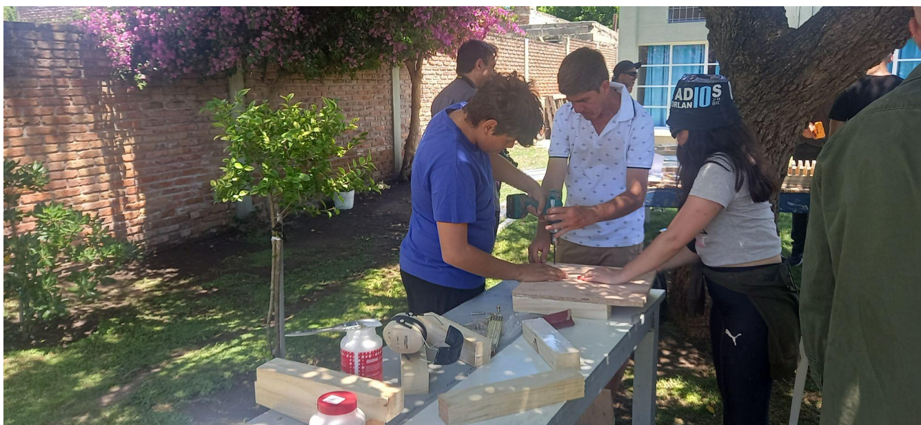
Construcción de equipamiento urbano. Estudiantes de CECAP y FADU bajo la orientación del Taller de carpintería de CECAP.
